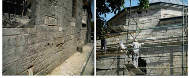
Fotoğraf 24. Taş çürütme sonrasında sağlamlaştırma işlemi, 2011 (Ebru Sünnetçi)
