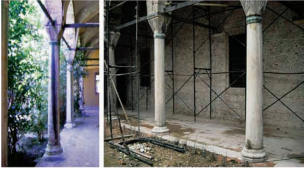
Fotoğraf 17. İmaret revak sütunları: Kimyasal temizlik öncesi (Solda), kimyasal temizlik sonrası (Sağda), 2011 (Ebru Sünnetçi)
