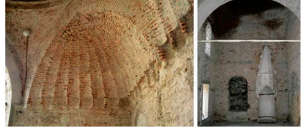
Fotoğraf 21. Darrüşifa: Çimento sıva raspası sonrası, 2011 (Ebru Sünnetçi)
