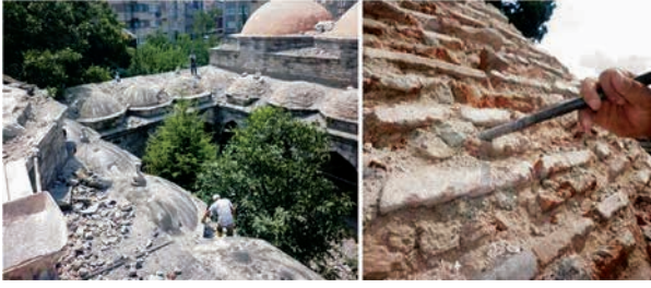
Fotoğraf 20. İmaret kubbeleri: Kurşun taklidi çimento şap ve çimento harçlı derz raspası yapılırken, 2011 (Ebru Sünnetçi)
