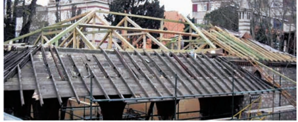
Fotoğraf 25. Sıbyan Mektebi çatısı sağlamlaştırma işlemi, 2011 (Ebru Sünnetçi)
