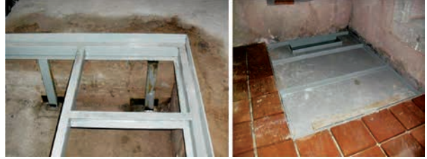
Fotoğraf 26. Döşeme altına tesisat yerleştirilmesi, 2011 (Ebru Sünnetçi)
