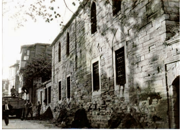
Fotoğraf 6. Haseki Mektebi'nin Haseki Caddesi Cephesi (Vakıflar Arşivi, 1967 onarım dosyası)
