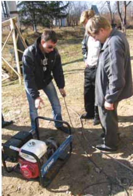
Специалисты РЦС запускают переносную электростанцию
