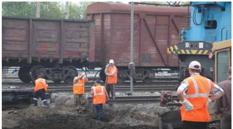
Разработка котлована под замедлитель на станции Алтайская
