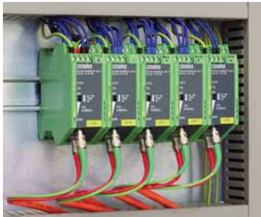
Опволоконные преобразователи PSI-MOS с контролем качества принимаемого сигнала
