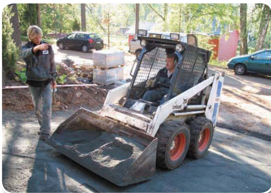
Työskentelyalueella olevien muiden työntekijöiden kanssa kannattaa sopia käsimerkeistä, joilla kommunikoidaan pienkuormaintyöskentelyn aikana. Kuva: Markku Lätti
