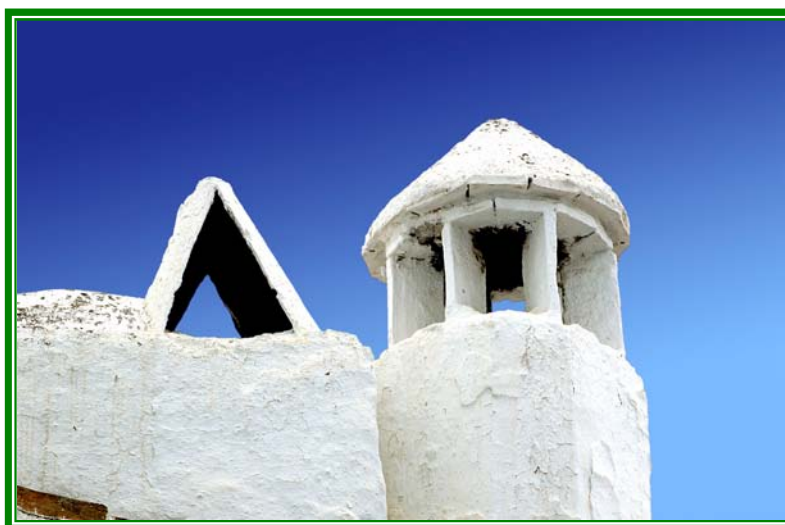
CHIMENEA CON MORFOLOGÍA SIMILAR A LA TORRE DE LA IGLESIA
