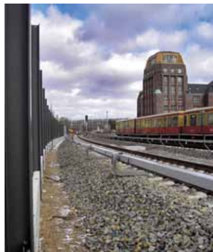
Nördlich der Ringbahnhalle werden gerade die Schallschutzwände gebaut
