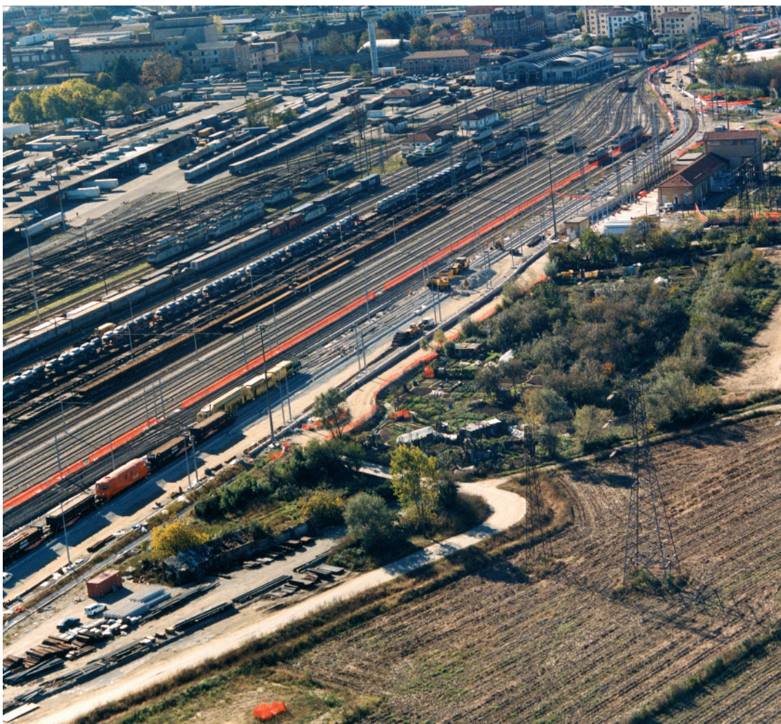
Scalo merci Boschetto e ultimo tratto dell'interconnessione Novara-Ovest/Realizzazione linea AV e nuova stazione FNM.
