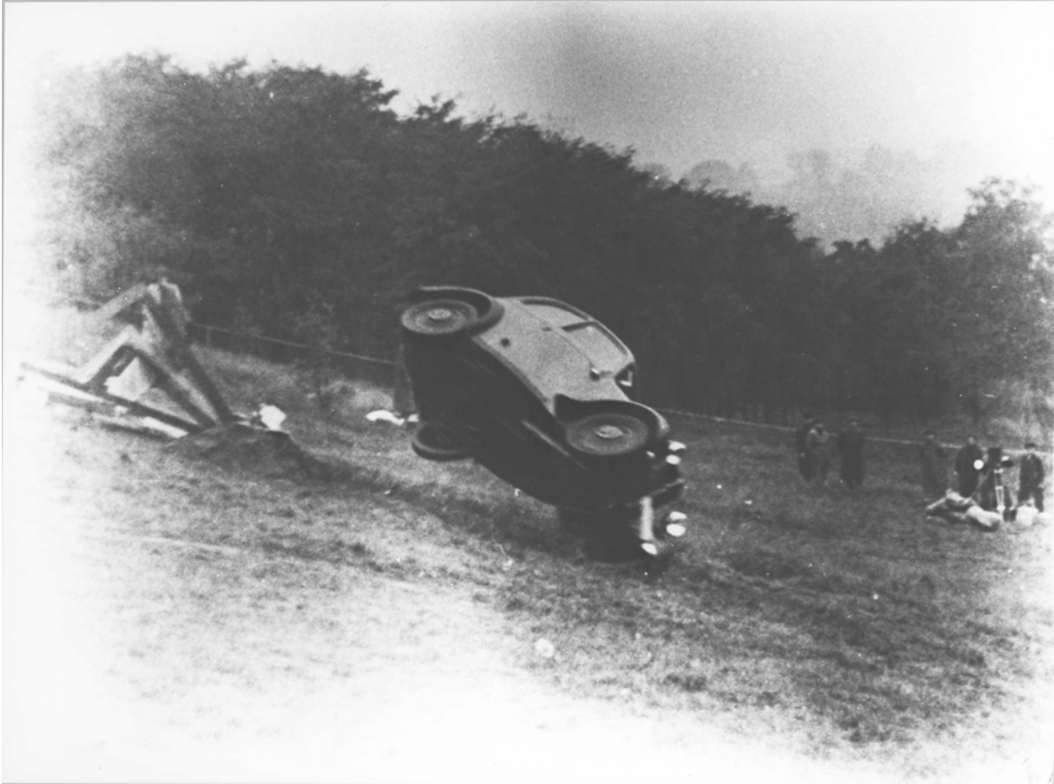
Abbildung 1: Überschlagtest DKW mit Kunststoffkarosserie (29.10.1938)
