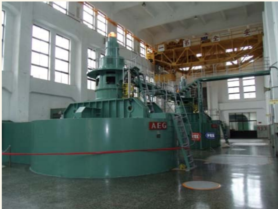
鉅工廠房內部。
