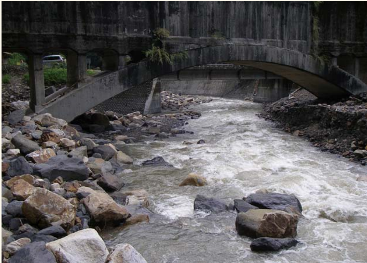
大觀一鉅工水陸橋，是台電人員每次巡視之重點區域。
