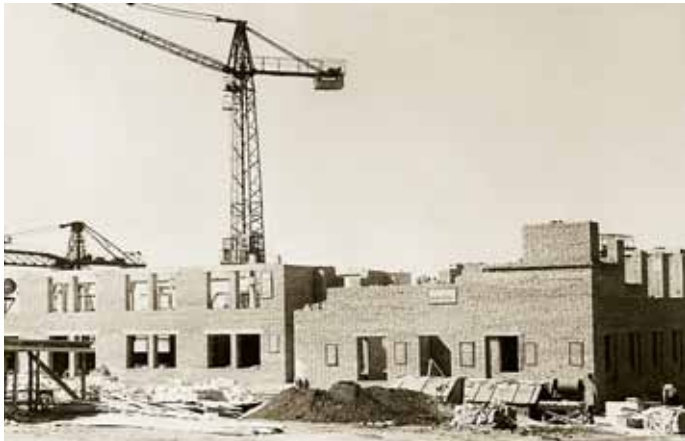
Строительство учебного корпуса на пр. Ленина, 1963–1964 гг.
