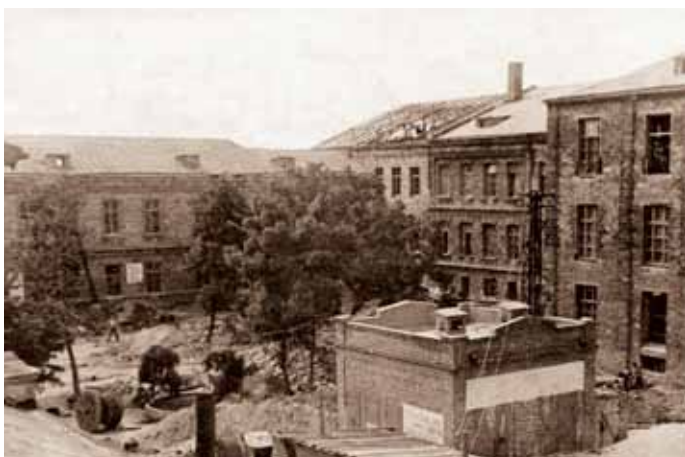
Разрушенное здание НКИ (вид со двора), 1944 г.
