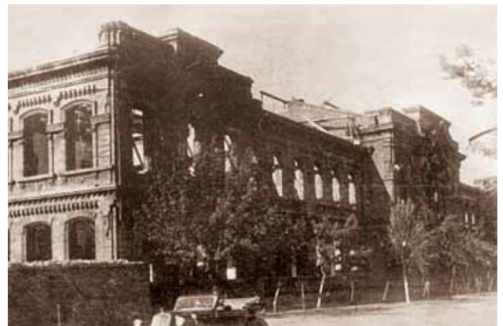
Разрушенное здание НКИ (вид с фасада), 1944 г.
