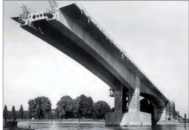
Abb. 4: Bau der Rheinbrücke Worms
