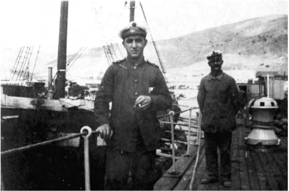
Κατά τον τελευταίο δεξαμενισμό του «Άρη» του Τσαμαδού (της Επανάστασης) στην παλαιά δεξαμενή του Ναυστάθμου Σαλαμίνας, ο υποναυπηγός Αλεξ. Φιλίππου περί το 1920-21.
