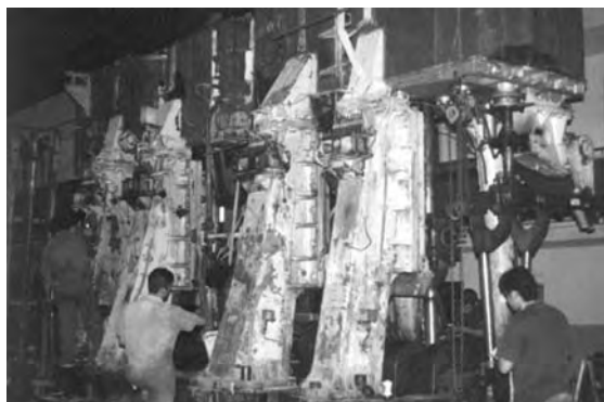
Η ατμομηχανή του «Χριστίνα» κατά την συναρμολόγησή της στο μηχανουργείο Καρρά στο Πέραμα.
