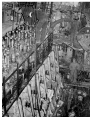
«Ωρίων». Η διαδικασία τοποθέτησεως της μίας μηχανής στη βάση της.
