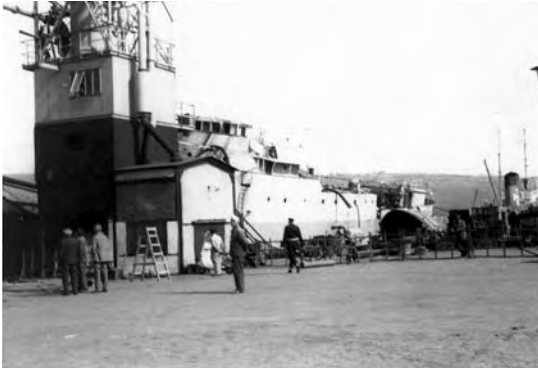
Η πρώτη σοβαρή πραγματογνωμοσύνη στη Σούδα της Κρήτης, τον Μάρτιο 1960. Το εικονιζόμενο γιουγκοσλαβικό φορτηγό είχε ανατραπεί ενώ εκφόρτωνε σιτηρά. Φυσικά δεν είχαν γίνει οι απαραίτητοι υπολογισμοί ευσταθείας φωτώσεως σιτηρών...
