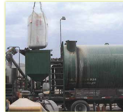
Figura 18. Detalle de la carga de caucho en las tolvas de la unidad
