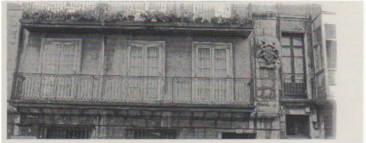
Ilustración 15- CASA MÁS ANTIGUA DE LA ZONA. N° 30 DE LA CALLE ALTA. LOS FERNÁNDEZ ESTRADA
