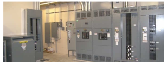
Representación gráfica del interior de una Subestación
