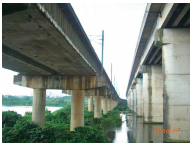
圖 38 台鐵大漢溪橋（第二大崙崙溪橋）
