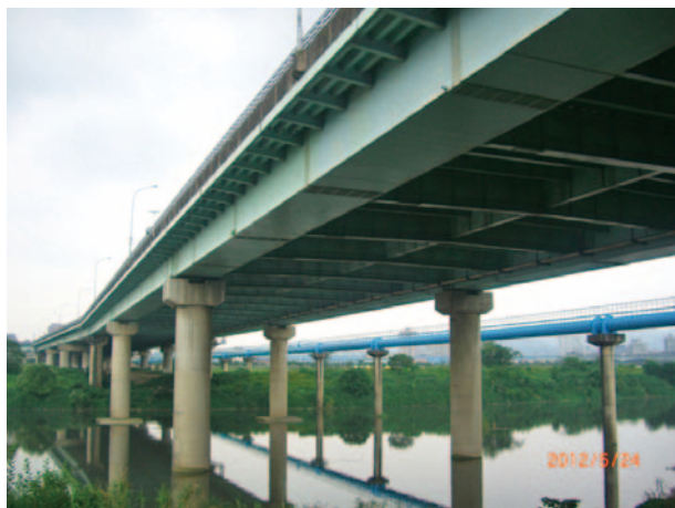
圖 36 浮洲橋及其下游水管橋
