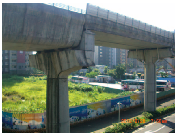
圖 43 捷運文湖線箱型梁及帽梁
