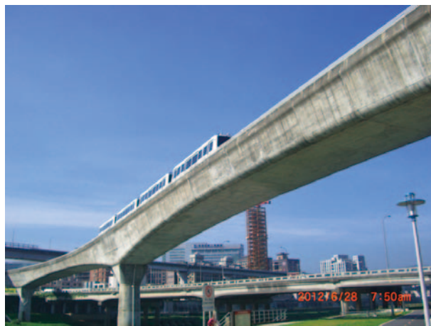
圖 42 捷運文湖線過河橋
