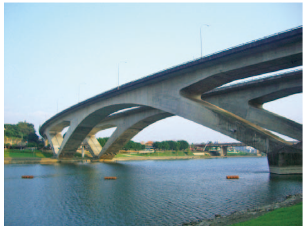
圖 3 北二高碧潭橋
