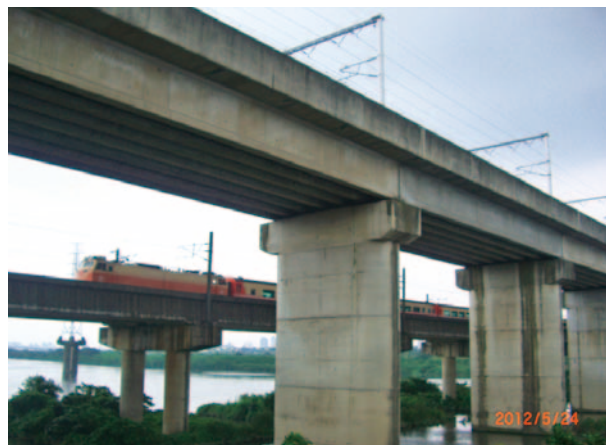
圖 37 高鐵大漢溪橋
