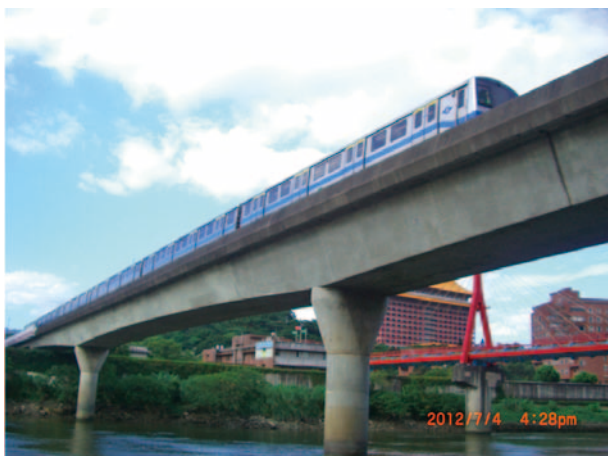
圖 56 捷運淡水線基隆河橋
