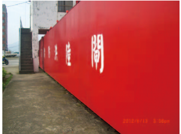
圖 57 百齡橋防洪陸閘
