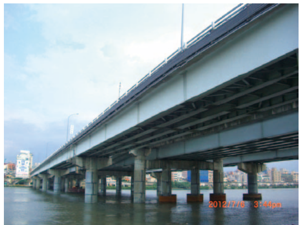
圖 65 鋼鈹梁造的台北大橋
