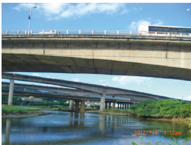
圖 52 圓山的高架橋梁
