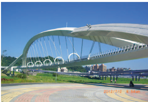
圖 8 陽光橋 遠方為中安大橋
