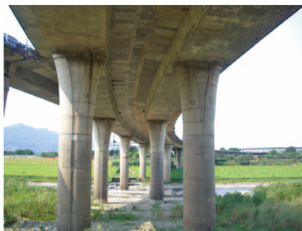
圖 6 安坑交流道安坑橋
