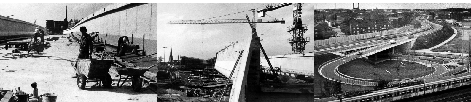
Bau der Schnellstraße „Münchener Straße“ in den Jahren 1978 bis 1980
