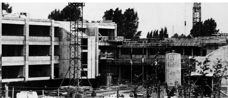
Am 20. August 1979 ist der Rohbau bereits erkennbar.
