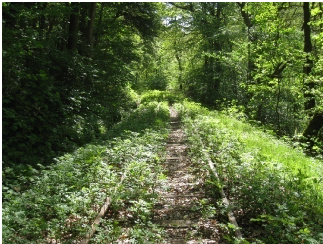
Figur 8. 33: Svær bevoksning i og uden for sporet
