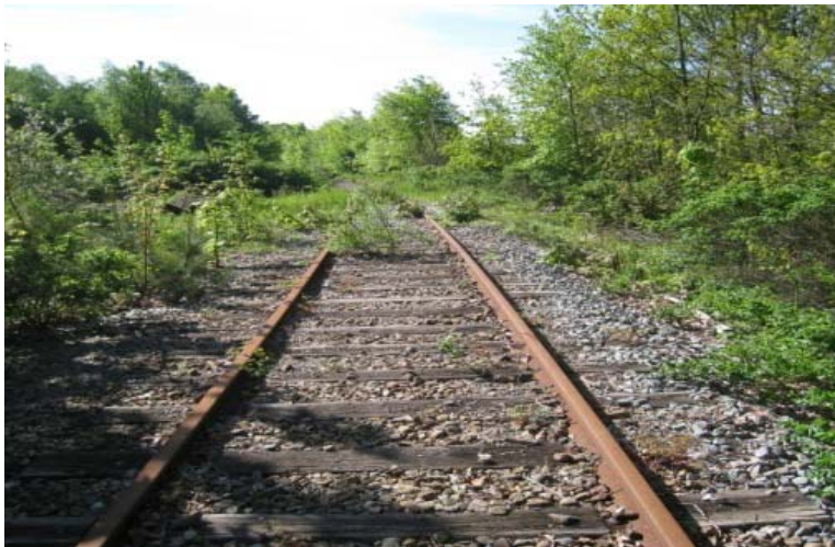
Figur 8. 31: Sveller med en udvekslingsprocent på 10
