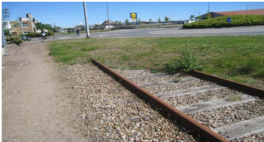
Figur 8. 28: Afbrudt spor ved Nordhavnsvej
