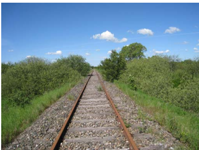
Figur 8. 18: Eksempel på relativt gode sveller, hvor udvekslingsprocenten er under 10
