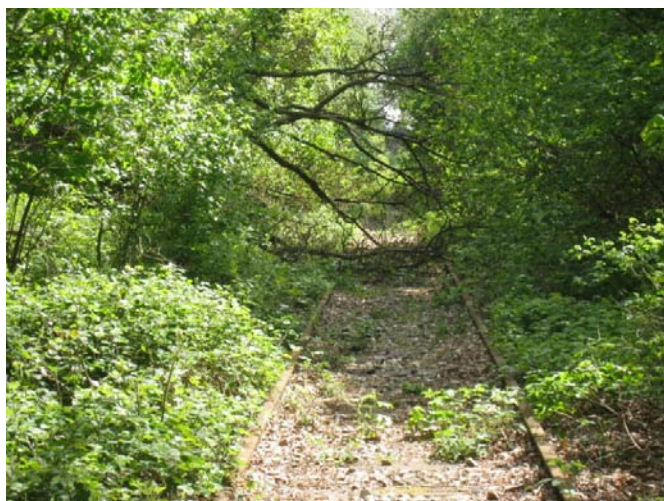
Figur 8. 21: Svær bevoksning i og uden for sporet
