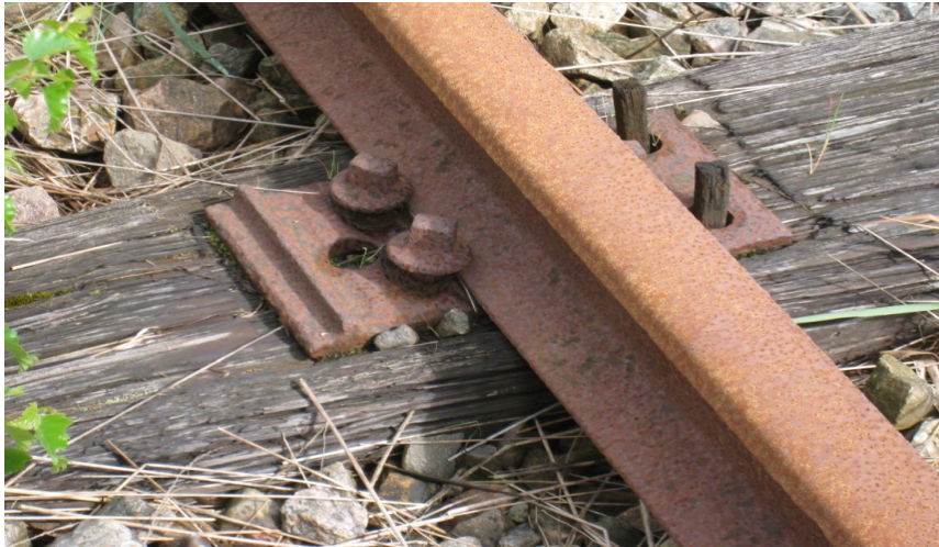
Figur 8. 4: Eksempel på svellekvalitet
