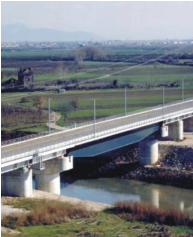
Il viadotto sul Volturno della linea AV/AC Roma-Napoli
