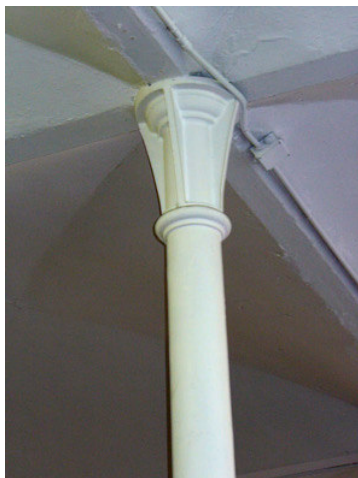
Particolare di una colonna in ghisa
