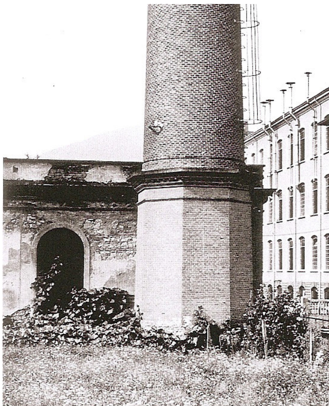
La base della ciminiera impostata su un podio ottagonale
