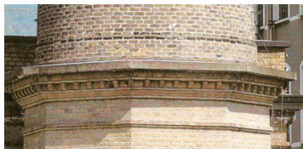
Particolare della cimasa profilata a dentelli
