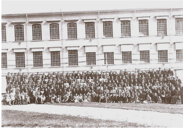
Una foto del prospetto ovest, scattata nel 1944, in cui si possono notare le mantovane e le tende ombreggianti
