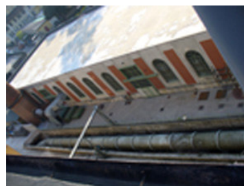
Il corpo di fabbrica del locale caldaia oggi ricostruito con a fianco il canale ridotto a una condotta
