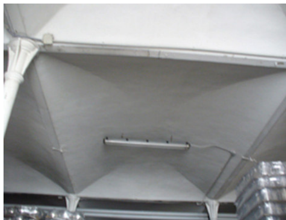
Particolare delle voltine a botte con teste a padiglione
