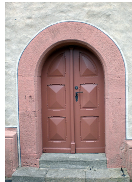
Der nördliche Außenaufgang zur Empore an der Nordwestecke der Kirche, 1589.
