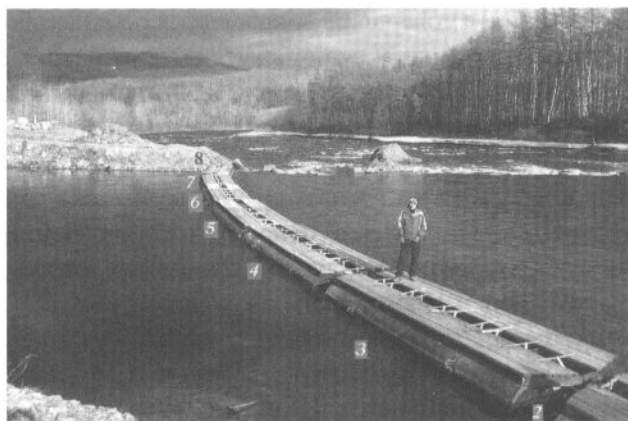
Рис. 11. Внешний вид РЗУ подводного канала Быстринской мГЭС-4 (цифрами обозначены номера понтонов)
