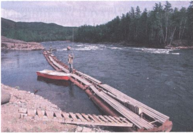
Рис. 1. Рыбозащитное сооружение жалюзийного типа, установленное на водозаборе подводящего канала Быстринской мГЭС-4 (май 2005 г.)
