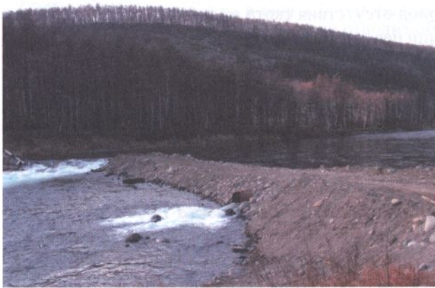
Рис. 3. Временная дамба в русле р. Быстрой — вид снизу, ниже водозабора Быстринской мГЭС-4 (октябрь 2007 г.)
