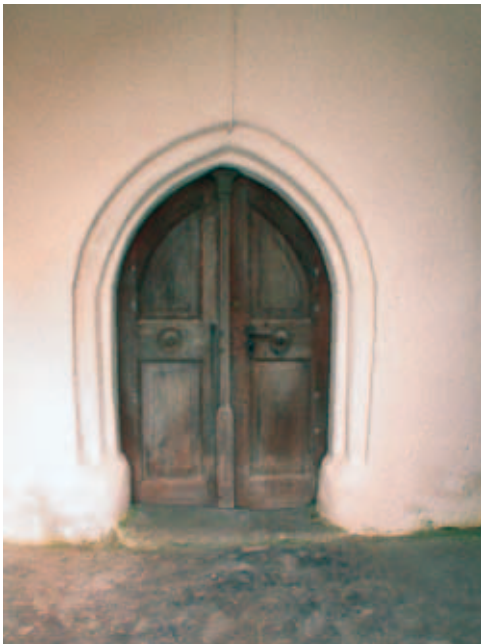
Das Nordportal hat eine massive Holztür. Rechts oben Durchblick zum Südportal.
