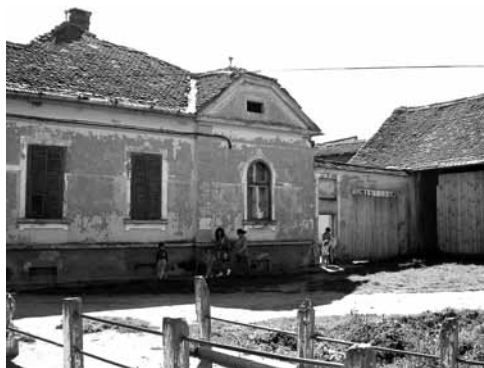
Das Gebäude des Kindergartens hat auch schon bessere Zeiten gesehn.
