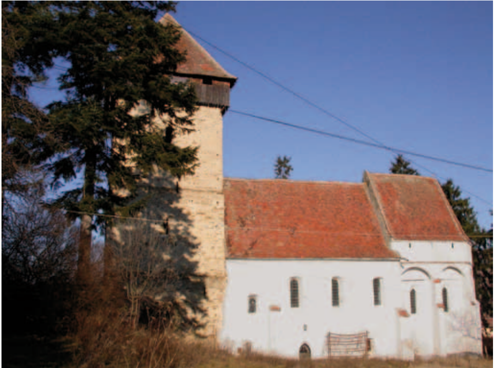
Die weiß getünchte Wand der evangelischen Kirche steht im scharfen Kontrast zum Kirchturm, dem ehemaligen Wohnturm der Gräfen, der aus Fluss- und Bruchsteinen gebaut wurde.
