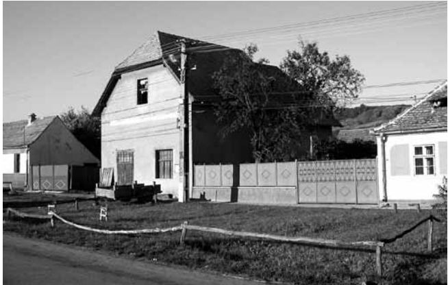
Haus 118: So sieht die Mühle von 1926 heute aus.
