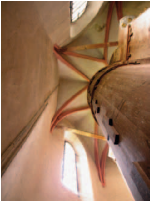
Ein ungewöhnlicher Blick nach oben fällt auf das Netzgewölbe hinter dem Altar.
