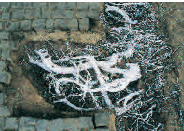
Links oben und links unten: Wurzeln in tieferen Schichten verursachen vergleichsweise geringe Schäden. Der kleinteilige Pflasterbelag passt sich der Anhebung außerdem an (Sophora, Wurzeln in Tragschicht, geweißt). Fotos: S. Reichwein
