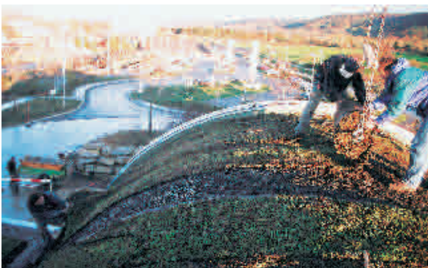
Ein fachgerecht geplantes und verlegtes Schubsicherungssystem.
