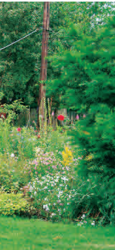
Sanierte Gartenlaube in einfacher Bauausführung in üppigem Ziergarten
