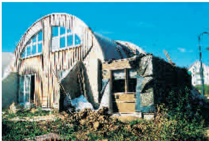
Blick auf die Dachabdichtung nach dem Abräumen des Substrates.
