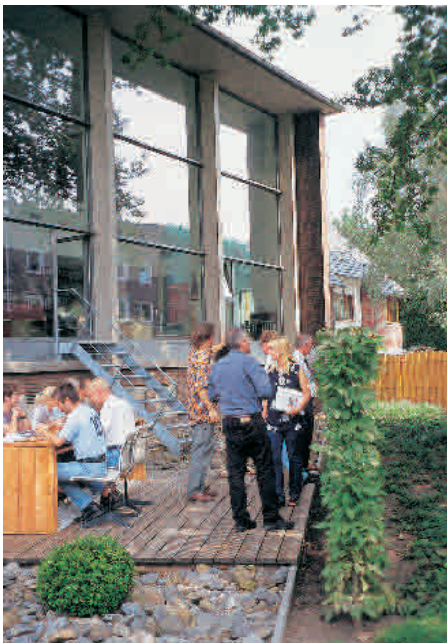
1. Preisträger. Der Firmensitz der Bürogemeinschaft Werk 3 ist ein ehemaliges Umspannwerk, dessen Südfassade vollständig verglast wurde. Auf diese Weise wird eine natürliche Belichtung erreicht und die optische Verbindung mit dem Garten hergestellt. Planung: Werk 3 , Hannover, 2001.
