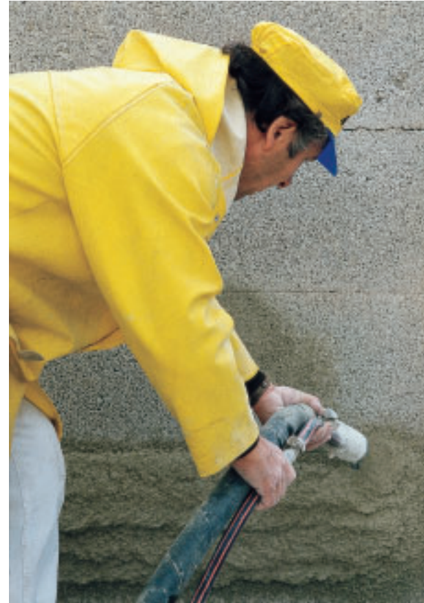
Aufspritzen des rhodipor ® -Dämmputz
