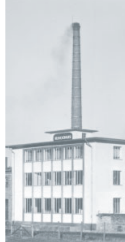
Teil der Produktions- gebäude in Fulda Ende der 60er Jahre.
