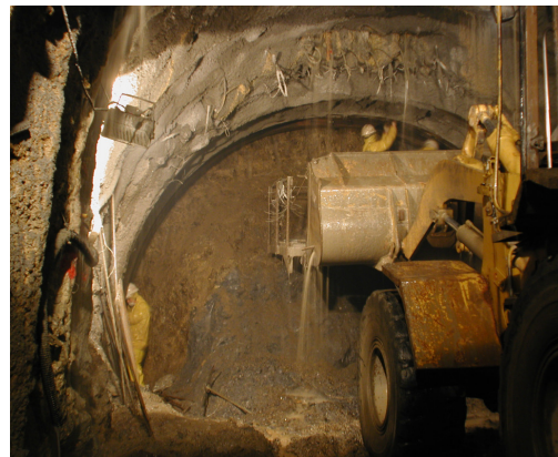
照片十 保留土心架設鋼支保
