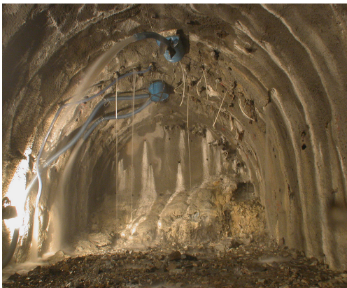
照片九 深排水孔遠端排水
