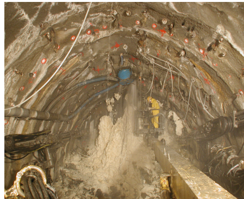
照片八 管幕及灌漿完成
