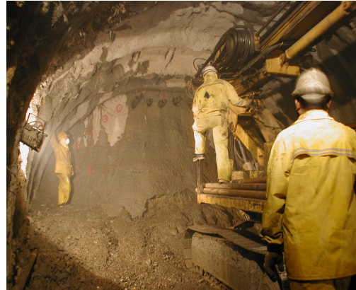
照片六 管幕鋼管施工
