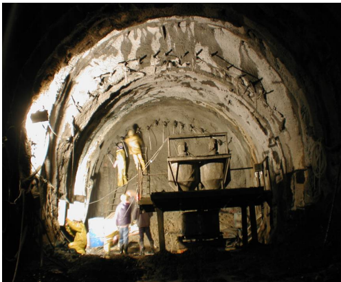
照片七 開挖面灌漿中
