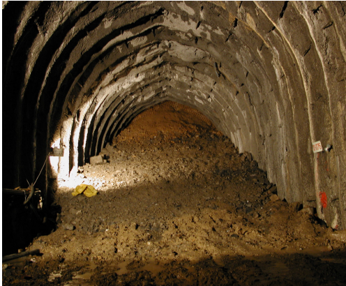
照片五 礫料回填穩定開挖面
