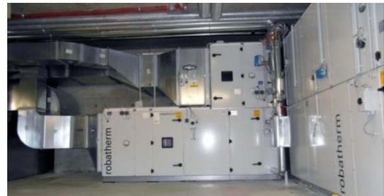
Lüftungsanlage (5 Lüftungszentralen mit Gesamtluftwechsel 160.000 m³/h)
