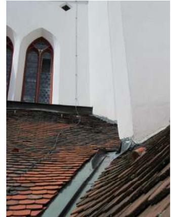
Undichte Verblechung führte zu Wasserschäden in der Sakristei
