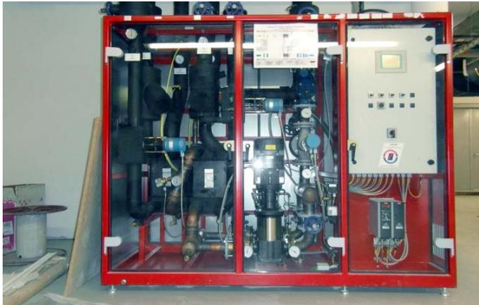
Wärmerückgewinnung mit Kreislaufverbundsystem
