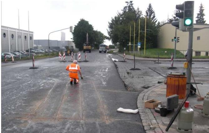
Einbau von Induktionsschleifen für die verkehrsabhängige Ampelsteuerung
