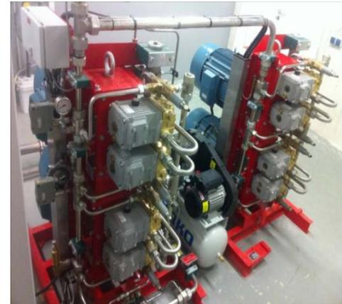
Hochdruckventile zur Löschwasserverteilung
