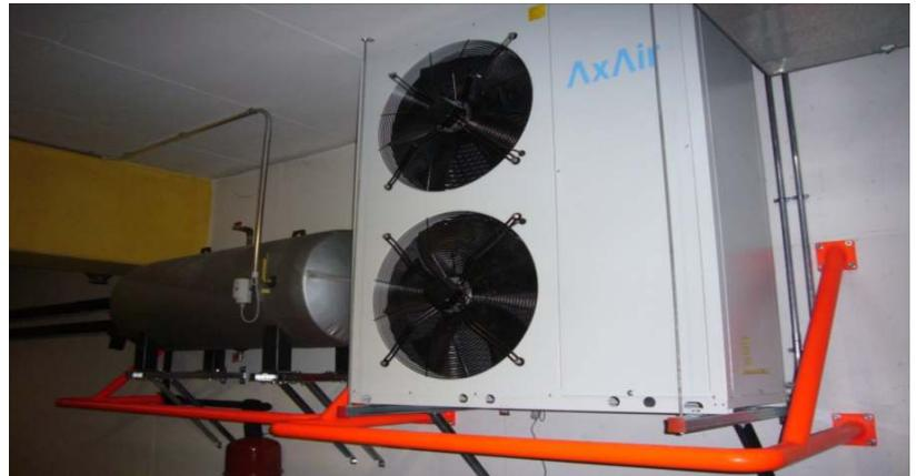
Kälteerzeugung zur Zuluftkühlung
