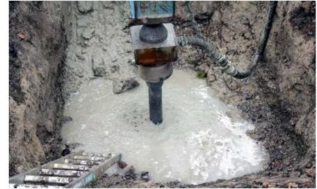
Hammer mit Anschluss für Verpressbeton
