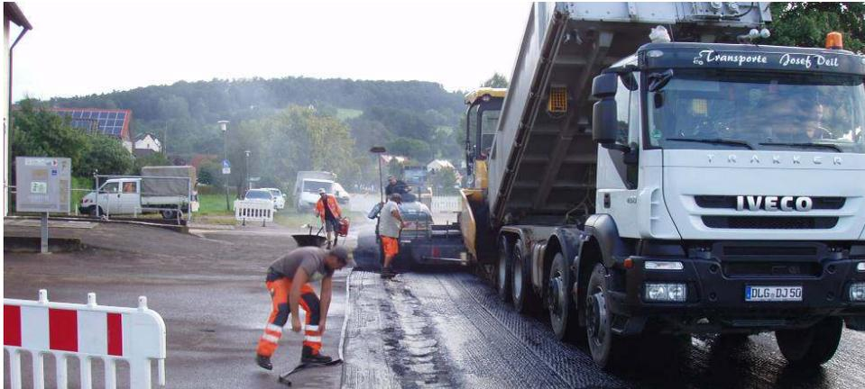
Herstellung der Deckschicht sowie der Anschlüsse an angrenzende Grundstücke
