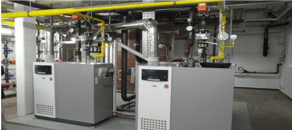
Doppelkesselanlage in Gasbrennwerttechnik
