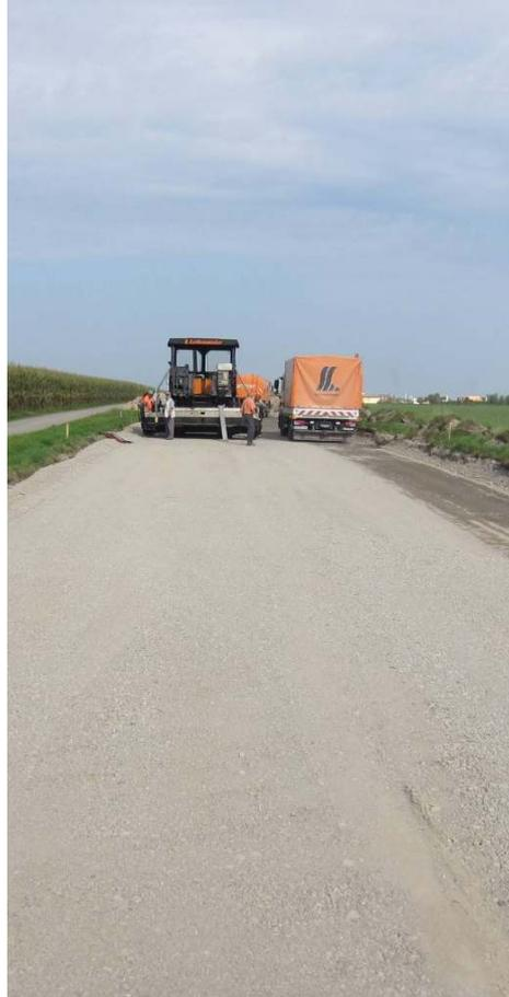
Einbau der hydraulisch verfestigten Tragschicht
