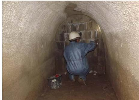
Ursprüngl. Zugang, Verschließen von Kleinöffnungen
