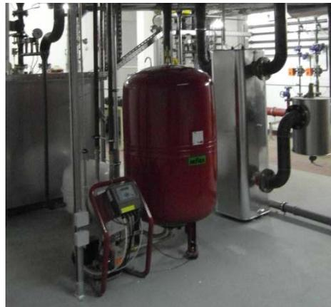
Ausdehnungsgefäß und Hydraulische Weiche
