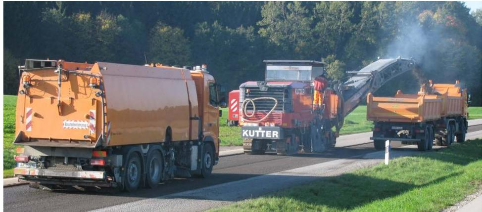
Fräsen und Reinigen der 30 Jahre alten Fahrbahn.
