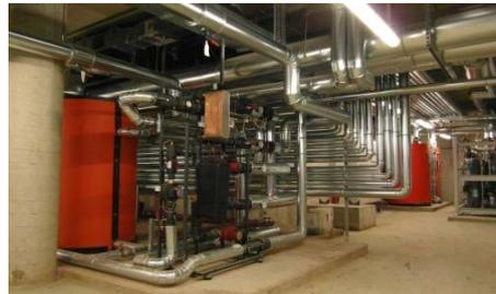
Brauchwasserverteilung mit Plattenwärmtauscher
