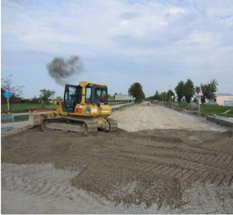
Einbau der Frostschutzschicht
