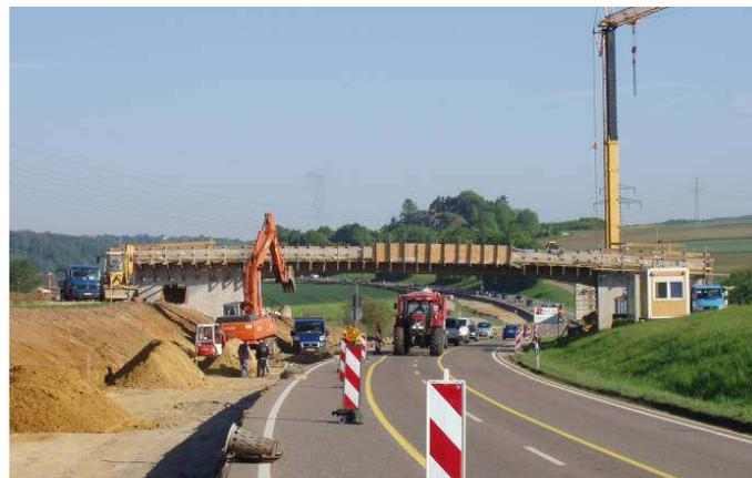
Anbau der 3. Fahrspur und Neubau einer Feldwegüberführung unter Verkehr
