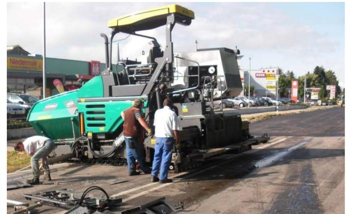
Abbau des Asphaltfertigers nach Fertigstellung der Asphaltdecke
