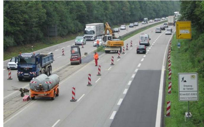
Herstellung der Mittelstreifenüberfahrten zur Überleitung des Verkehrs auf die Gegenfahrbahn
