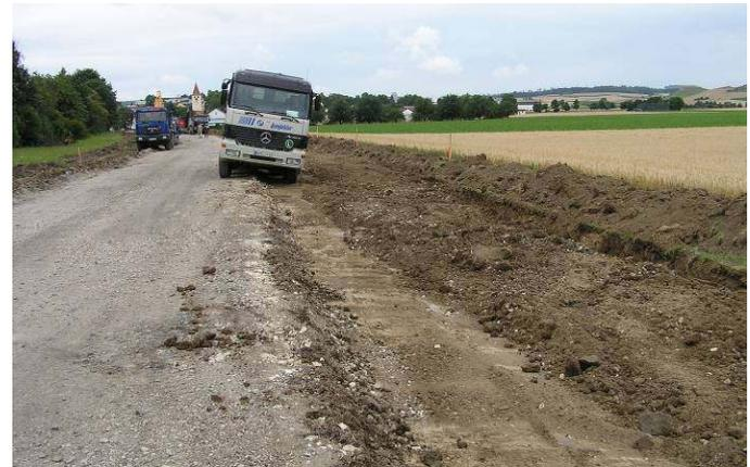
Nach dem Rückbau des Straßenkörpers wird mit der Herstellung des neuen frostsicheren Unterbaus begonnen
