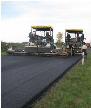
Einbau der Asphaltbetondeckschicht.
