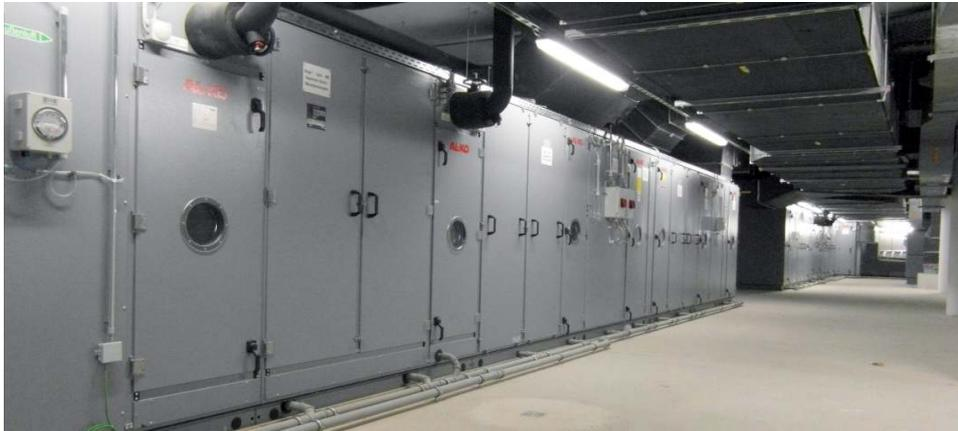
Lüftungszentrale mit zentraler Frischluftaufbereitung und Laborsonderabluft (55.000 m³/h)
