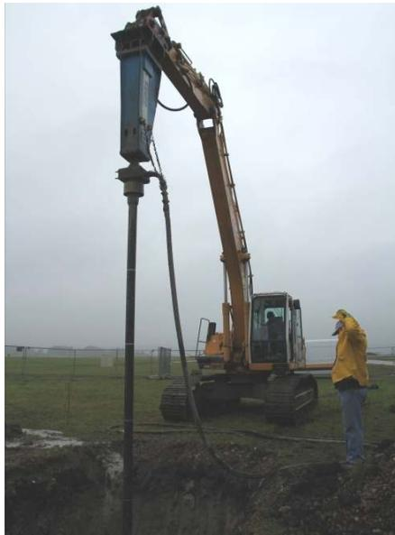
Bagger mit 2. Rohr an Hammer und Schlagstück
