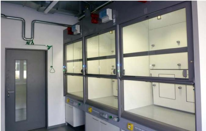
Digestorien mit temperaturgesteuerter CO<sub>2</sub>-Löscheinrichtung
