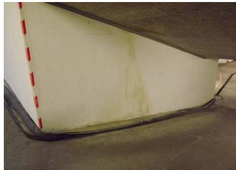
Verlauf Füll- u. Entlüftungsleitungen in der Tiefgarage
