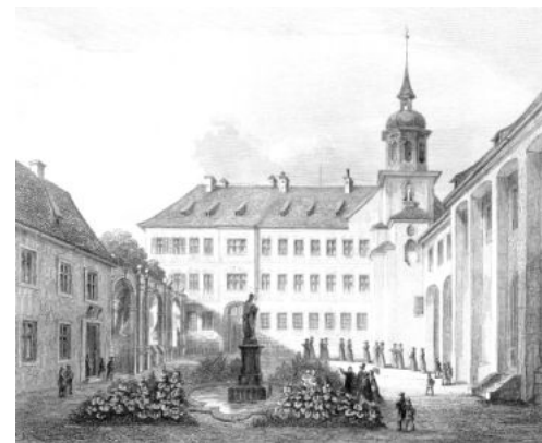
Domhof, Stahlstich um 1860
