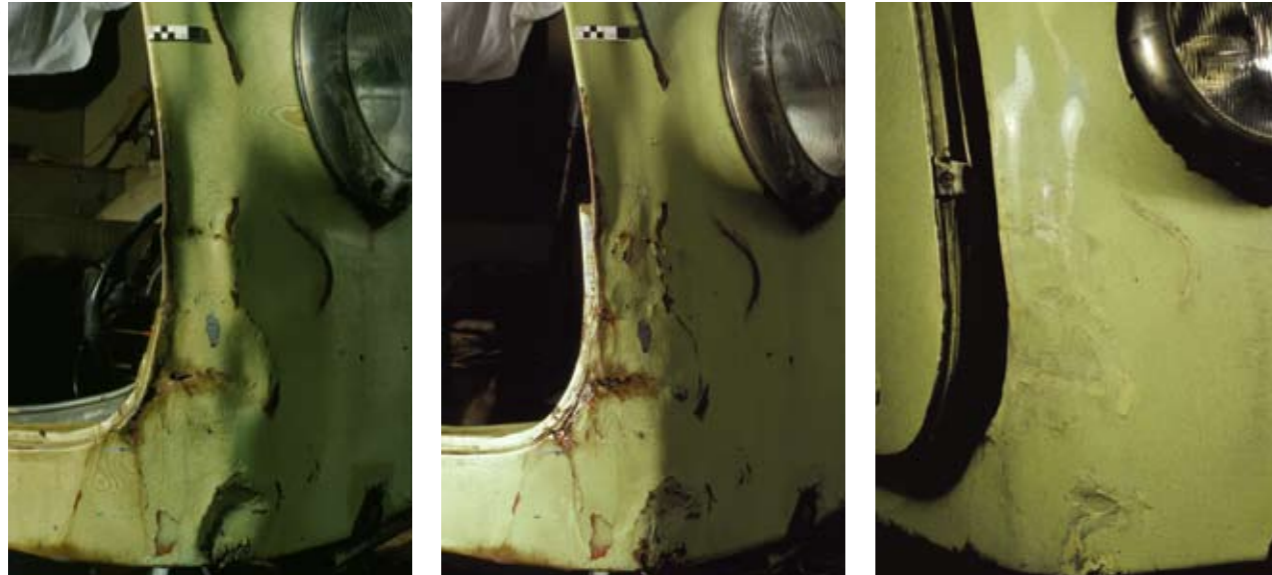
1 Front vorne rechts; Stauchung des Blechs behindert das Schließen der Tür und beeinträchtigt die einheitliche Form der Karosserie (Foto Karp)
