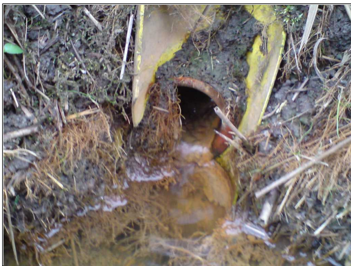
Foto 11. drainagepunt oostelijk sloot (3)
