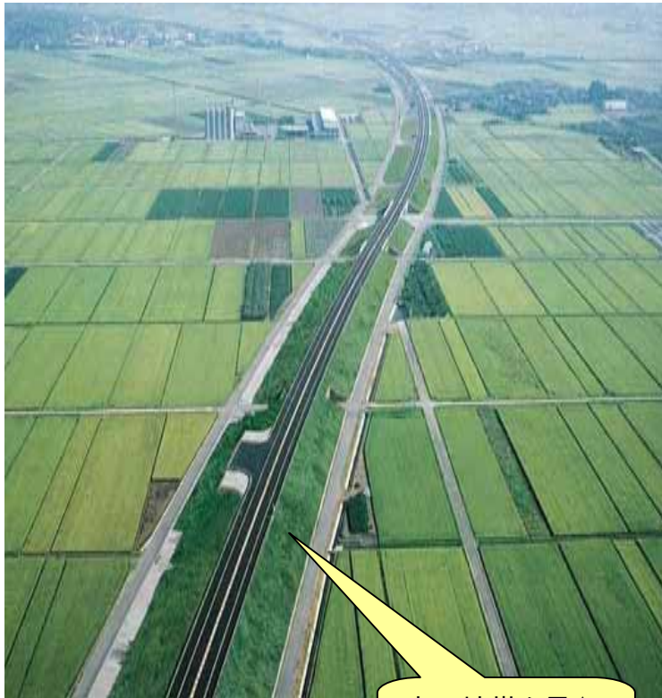
水田地帯を貫く 本線盛土
