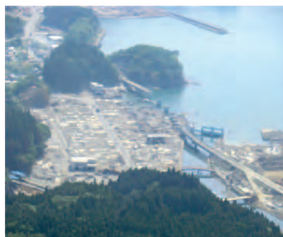
• 歌津伊里前地区の被災状況
