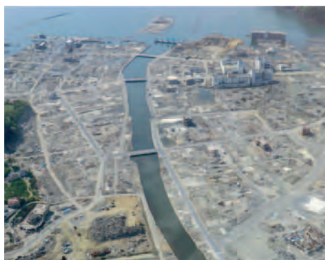
• 志津川地区の被災状況
