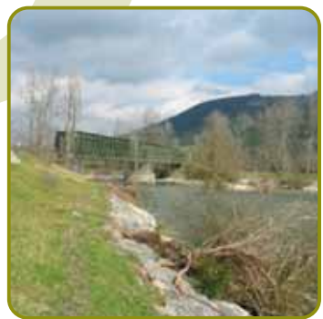
Puente sobre el río Pas.
