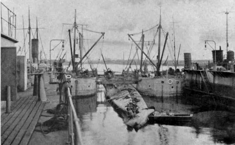
U 30 wird gehoben
