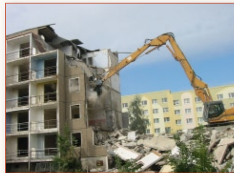
ABBRUCH UNSANIERTER GEBÄUDE ©GUWO
