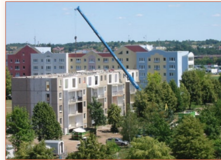
GESCHOSSWEISER RÜCKBAU IN DER KASTANIENSTRASSE ©GUWO
