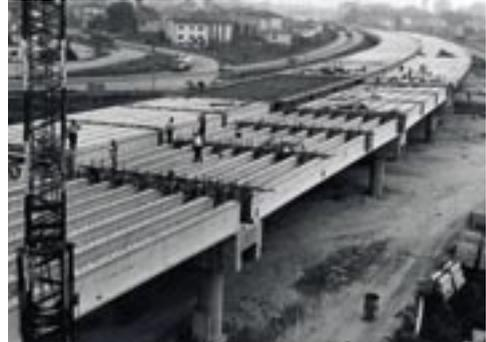
**46.** Inizio anni Settanta. Tangenziale in costruzione in corrispondenza della nuova rotonda di svincolodi Marghera. Si notino i vari stadi costruttivi realizzati in successione, dalle travature visibili in primo piano ai solettoni grezzi e finiti. Sullo sfondo le sagome della torre dell'acquedotto di Marghera e del quartiere Cita in via di completamento.
