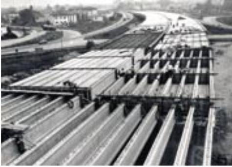
**45.** Inizio anni Settanta. Tangenziale in costruzione vista da sud, in corrispondenza della nuova rotonda di svincolodi Marghera. Si notino i vari stadi costruttivi realizzati in successione, dalle travature visibili in primo piano ai solettoni grezzi e finiti.
