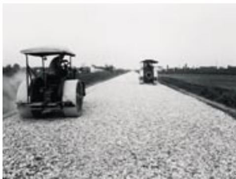
**16.** 1930-1933. Le macchine schiacciasassi al lavoro lungo la carreggiata in costruzione.
