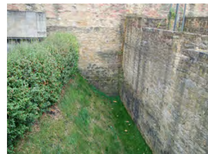
Grabenbereich zur Stadt
