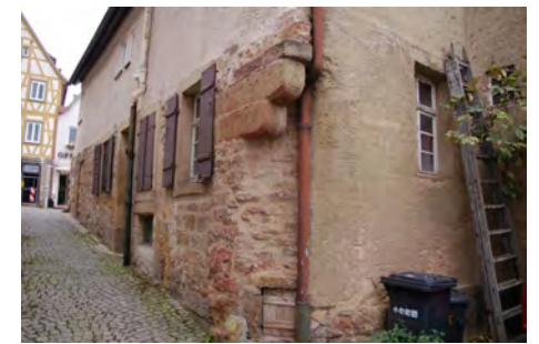
Rückwärtiges Nordosteck und Erdgeschoßzone
