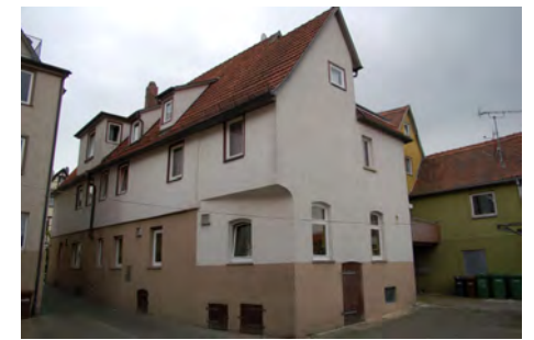
Rückansicht von Nordosten
