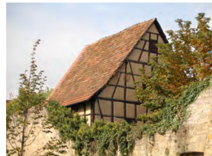
Scheune, von Südosten
