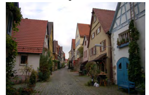
Von Mittlerer Holdergasse 11 nach Osten
