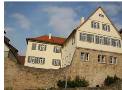
Von Süden über die Stadtmauer
