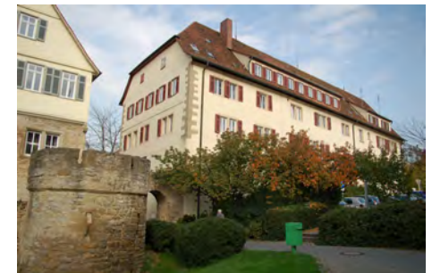
Ansicht von Südwesten mit Zwingerturm
