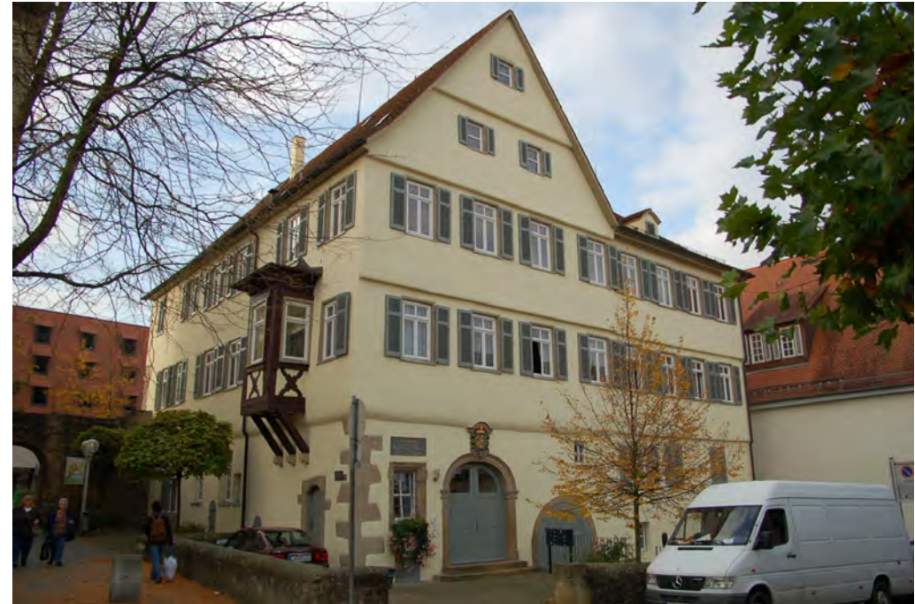
Ansicht von Nordosten mit Durchgang in der Stadtmauer
