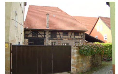
Hofmauer und Scheune, Ansicht von Osten
