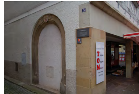
Detail vermauerter Seiteneingang
