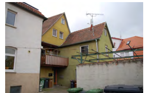
Rückansicht von Nordosten
