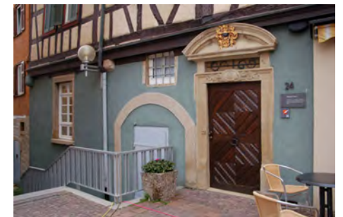
Detail westliche Erdgeschoßzone
