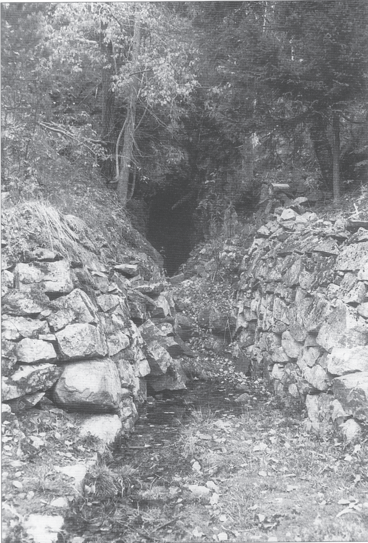
Mundlocken ved Nedre Stoll ble delvis ødelagt da driften ble forsøkt gjenopptatt på slutten av 1800-tallet, og den steinsatte vannrenna har grodd igjen. En restaurering av dette er blant de arbeidsoppgavene Skara Sølvgrubers Venner har planer om å ta fatt på. (Foto: Bent Ek).
