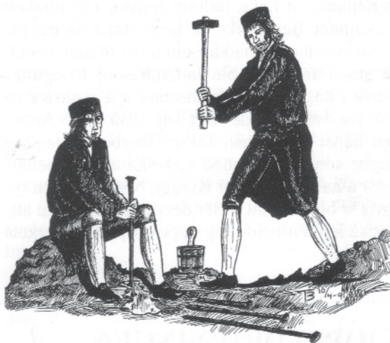
Borhauere lager hull til kruttspredning.
