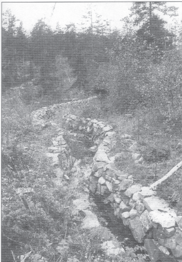
I tilknytning til sagbruket og pukkverket ble det bygd ei nesten 100 meter lange vannrenne. Vannet ble ledet fram til vannhjulet gjennom trerør, som var isolert mot frost ved hjelp av rosentorv. Steinmuren, som ble bygget for å hindre at torven raste ut, er blitt satt i stand av Skara Sølvrubers Venner.
