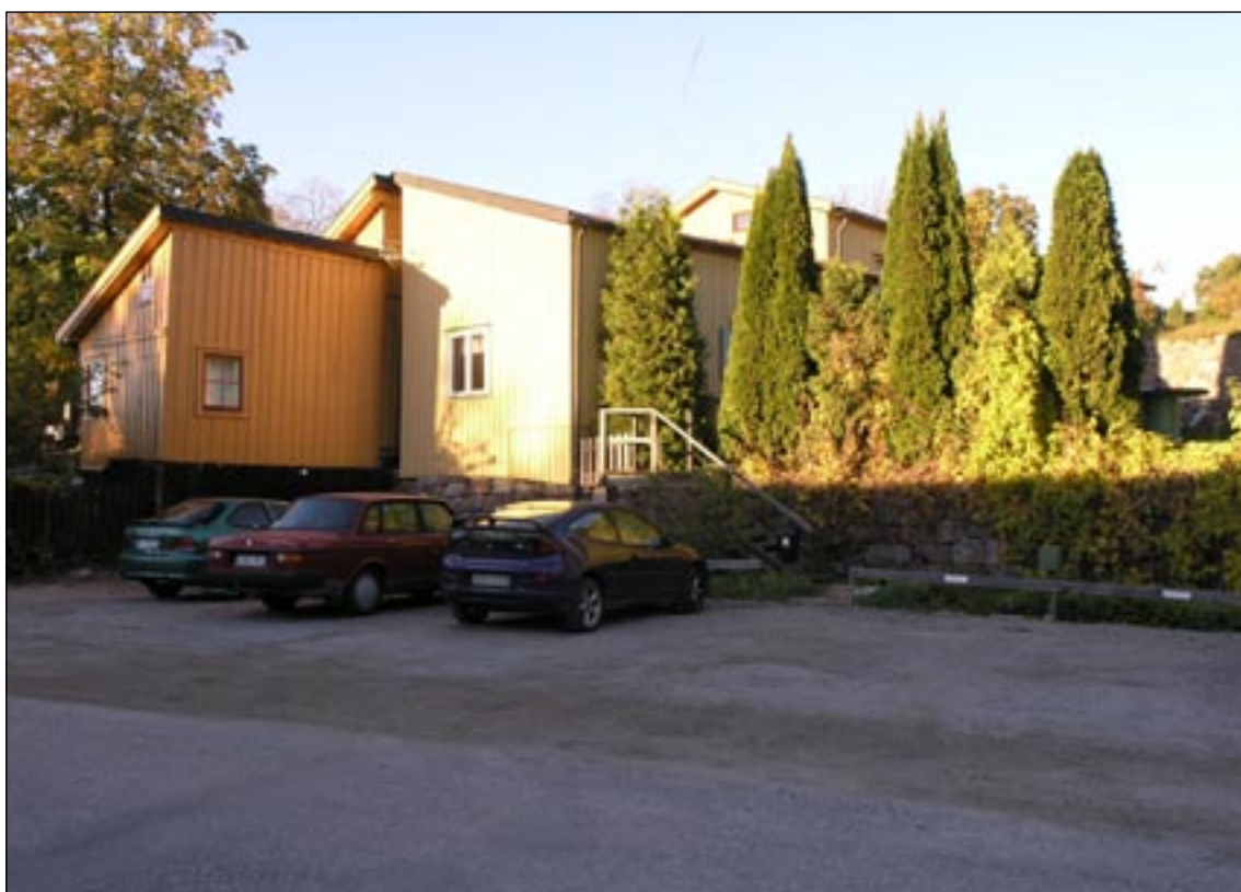
Utbuslänga uppförd i tomtgränsen vägg i vägg med utbuslängan på intilliggande tomt. Fastigheterna Marieberg, Drottningholm 1:24 och Nedre Svanteberg, Drottningholm 1:55. Bildnummer: lp20051334
