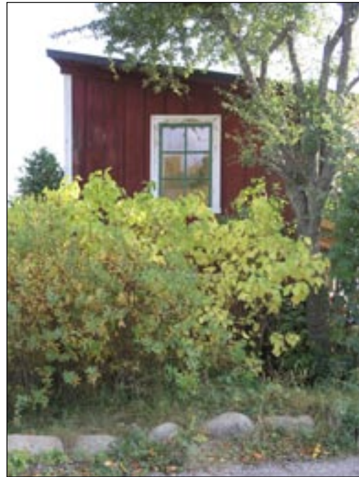
Utbus, ombyggt till bostadsbus, med pulpettak täckt med papp. Fastigheten Klippan, Drottningholm 1:20. Bildnummer: lp20051113
