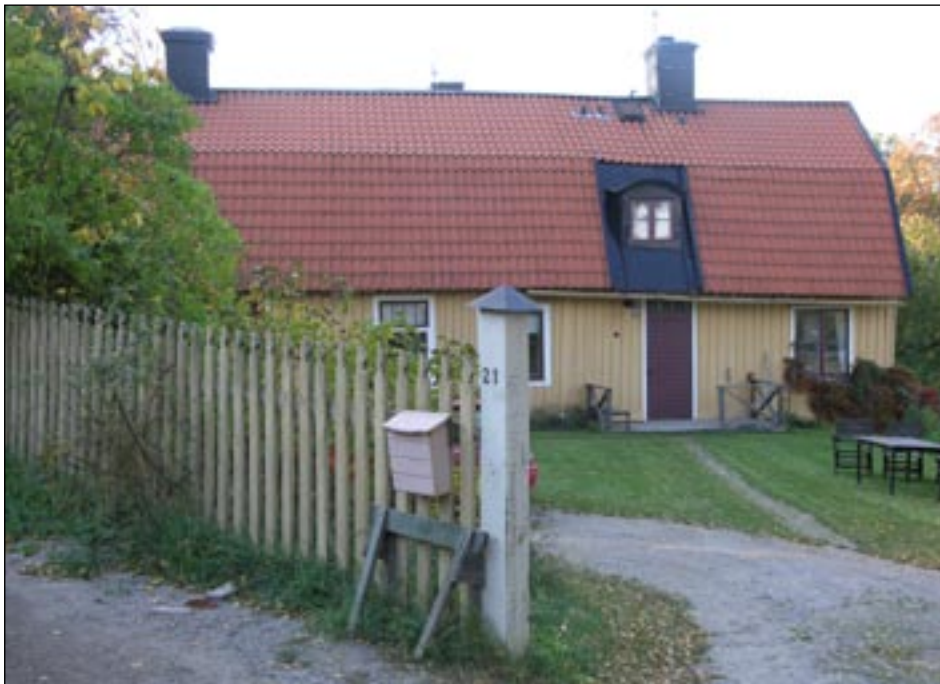
En av Drottningholmsmalmens äldre stallbyggnader ombyggt till bostadshus. Drottningholm 1:56. Bildnummer: lp20051140
