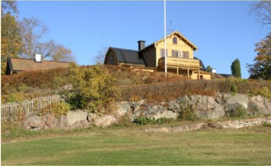
Övrig bebyggelse är oftast uppförd på en hög punkt anpassad efter tomtens förutsättningar. Nedre Svanteberg, Drottningholm 1:55. Bildnummer: lp20051226
