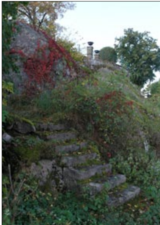
Anlagd trappa i terrängen, fastigheten Lilla Klemmingsberg, Drottningholm 1:44. Bildnummer: lp20051348
