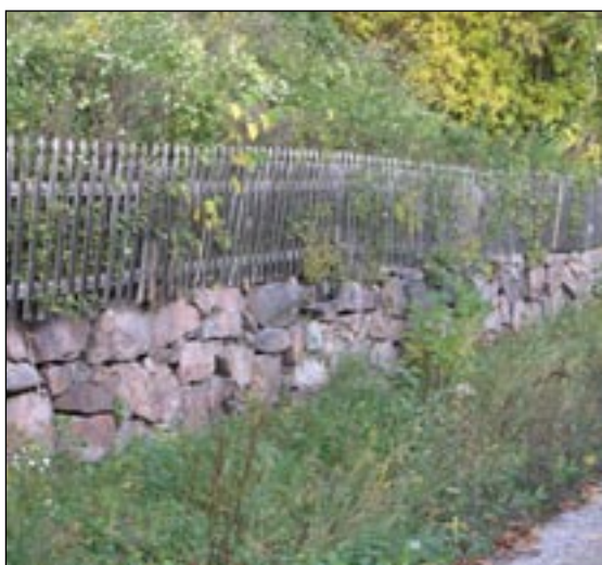
Vanligt förekommande är spjälstaket på naturstenssockel med växtlighet som tränger ut över staketet. Fastigheten Bergabo, Drottningholm 1:31. Bildnummer: lp20051339
