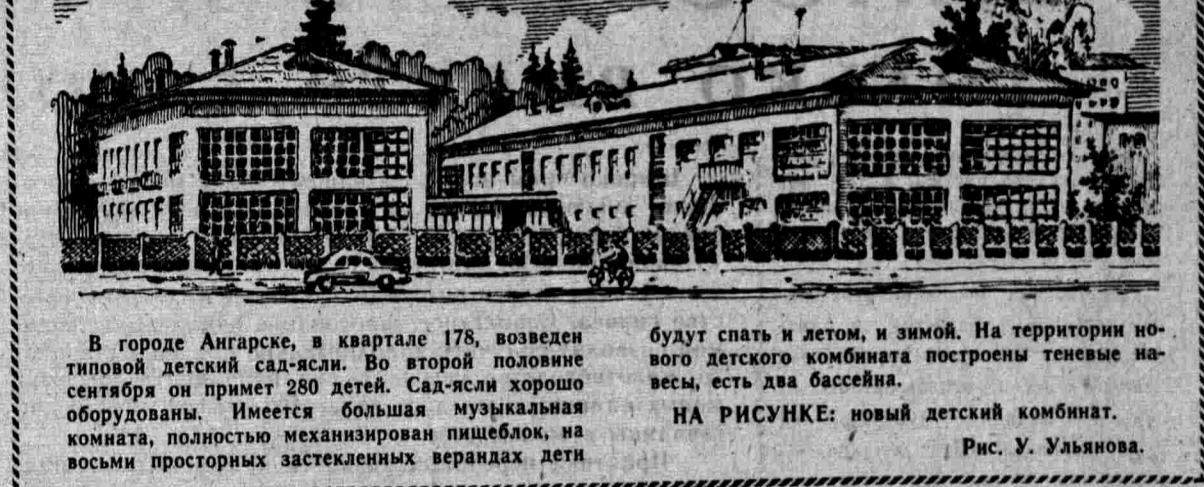
В городе Ангарске, в квартале 178, возведен типовой детский сад-клуб. Во второй половине сентября он примет 280 детей. Сад-клуб хорошо оборудован. Имеется большая музыкальная комната, полностью механизирован пищеблок, на восьми просторных застекленных верандах дети будут спать и летом, и зимой. На территории нового детского комбината построены теневые навесы, есть два бассейна. НА РИСУНКЕ: новый детский комбинат. Рис. У. Ульянова.
