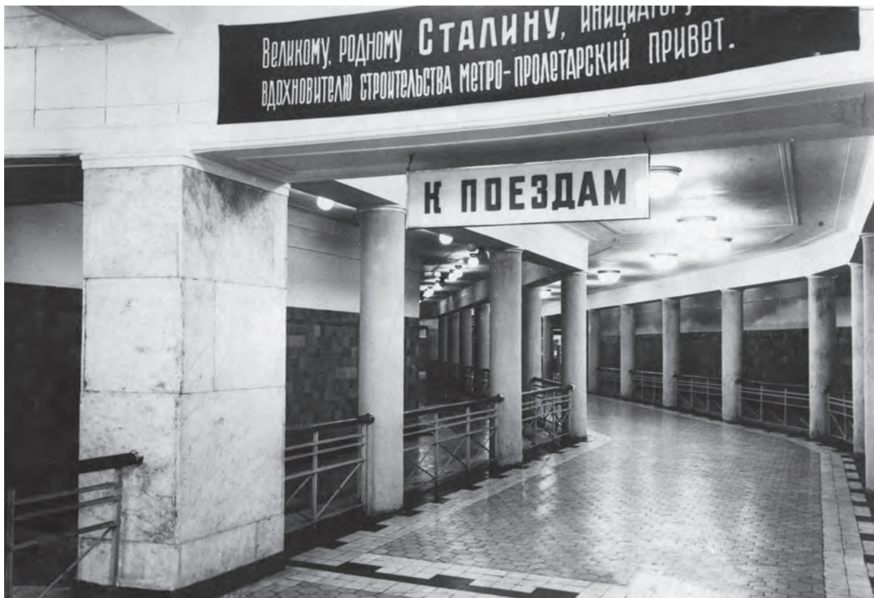
На примере станции «Сокольники» отчетливо видна функциональная направленность в оформлении первой линии метрополитена — станция должна, в первую очередь, обеспечить удобство для передвижения пассажиров
