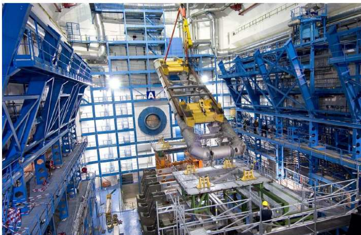
Фотография начала монтажа элементов баррель тороида ATLAS в подземной шахте.
