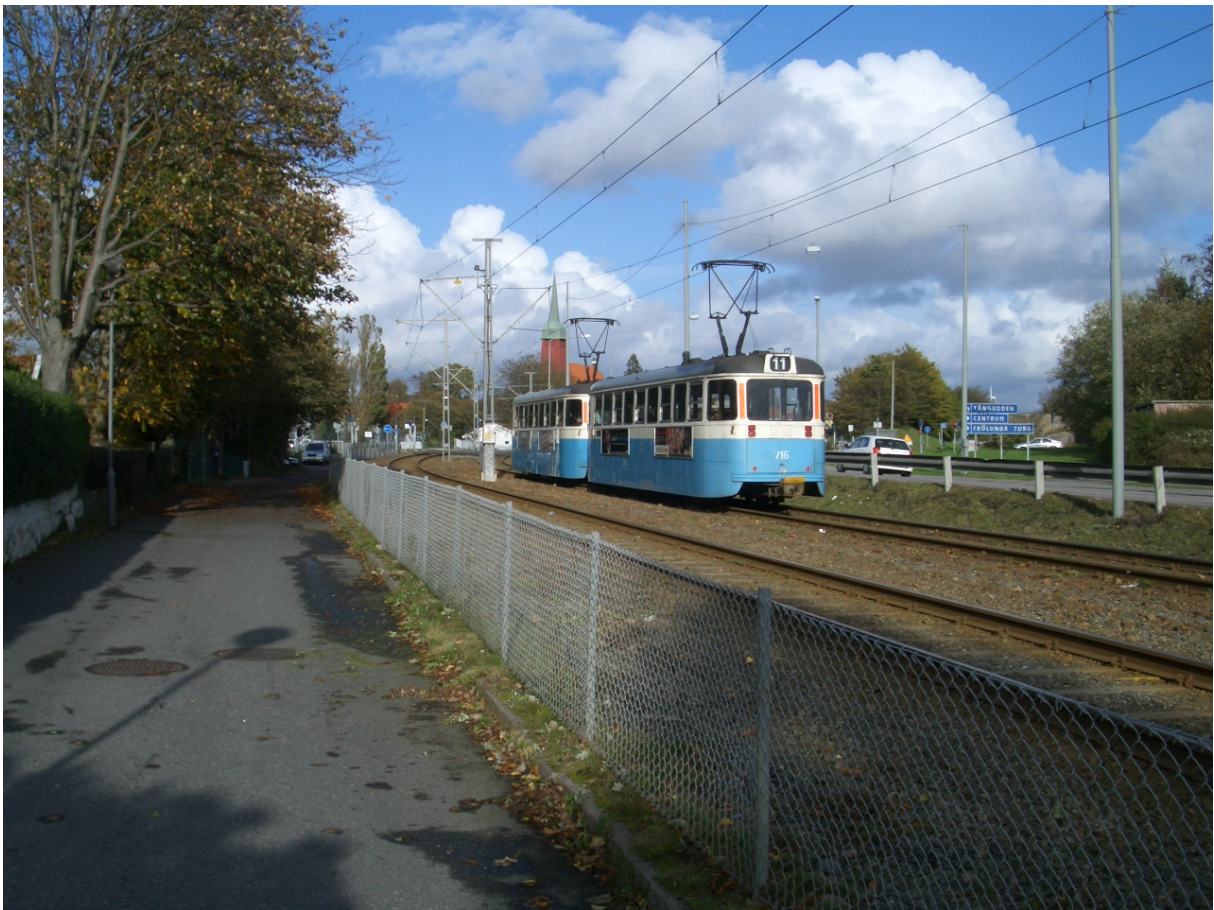
Foto 5: Eksempel på reserveret letbaneområde. Linje 11 sidelagt i Torgny Segerstedts gatan i Göteborg oktober 2011. Der er opsat autoværn mellem letbanen og køresporene.
