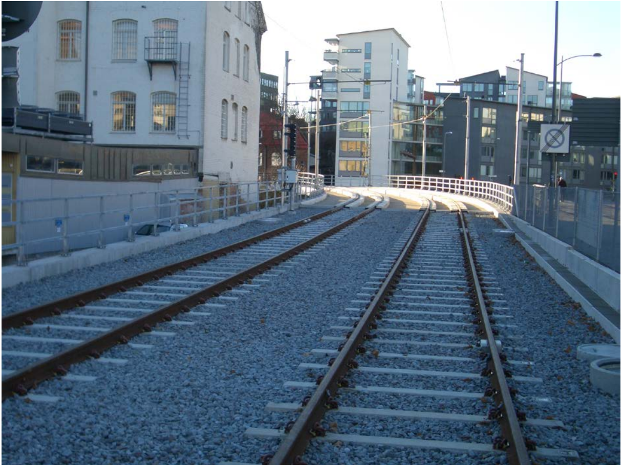
Foto 4: Eksempel på uafhængigt letbaneområde. Forlængelsen til Solna station af Tvärbanan i Stockholm november 2012. Tvärbanan passerer her Bällsta Ån på en ny bro anlagt alene for letbanen. Ibrugtages til Solna Centrum sommeren 2013.
