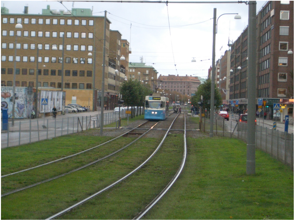
Foto 2: Exempel på reserveret letbaneområde. Linje 3, 9 og 11 midterlagt i Första Långgatan i Göteborg oktober 2011.
