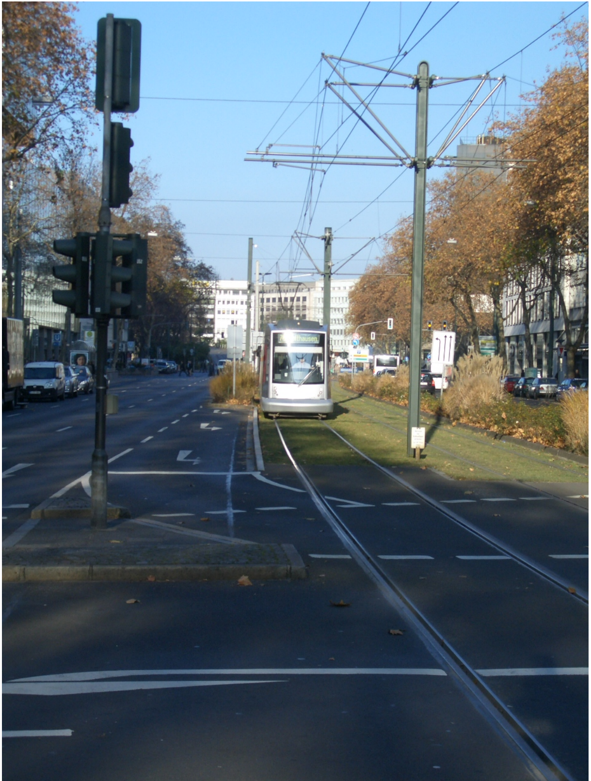
Foto 6: Eksempel på svingbane for bundet venstresving på Berliner Allee i Düsseldorf november 2011. Pga snævre pladsforhold er det valgt at adskille venstresving-banen fra ligeud-køresporene ved hjælp af et såkaldt "griseøre". Adskillelsen muliggør at de venstresvingende kan gives en særligt styret fase i signalreguleringen, der sikrer mod at de svingende danner kø hen over letbaneområdet. Hvis pladsforholdene tillader det bør der anvendes en normal skillerabat mellem venstresving-banen og ligeud-køresporene. Sidstnævnte løsning er valgt på letbanen på Ring 3.
