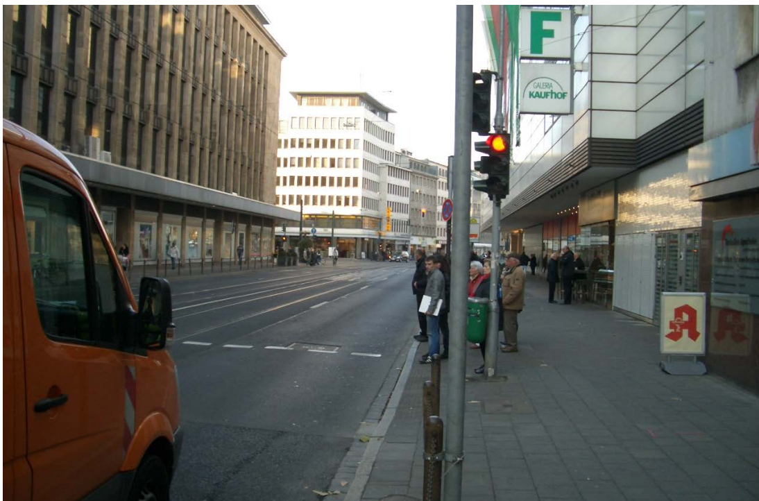
Foto 12: Eksempel på station med "tidsperroner" (EAÖ: "Zeitinsel") i Tonhallenstrasse i Düsseldorf november 2011. Stationen er med hensyn til signalregulering indrettet som forudsat i i fig 8. Letbanesporene er dog ikke som på fig 8 sænket i forhold til køresporet, således at man opnår niveaufri indstigning fra perron til vognulv. I den viste udformning kan løsningen derfor ikke anvendes ved nyanlæg i Danmark.
