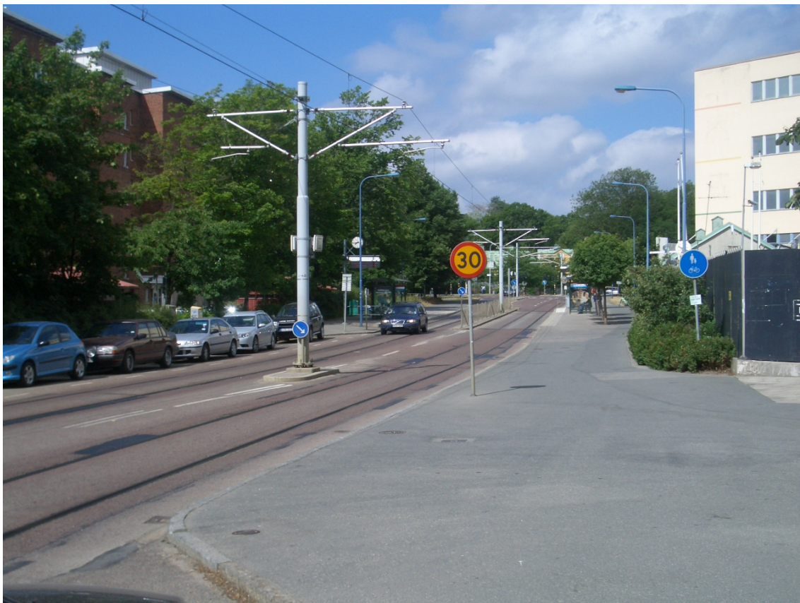
Foto 13: Eksempel på station i fælles letbaneområde svarende til fig 9. Hegn mellem letbanesporene forhindrer at bagfra kommende biler overhaler et holdende letbanetog og tvinger derved de bagfra kommende biler til at afvente at et holdende letbanetog igen sætter i gang. Cykelstierne er ført bag om perronerne. Trekanten station på Tvärbanan i Stockholm sommeren 2010.
