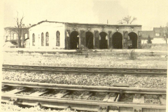
Die letzte Hälfte des Lokschuppens
