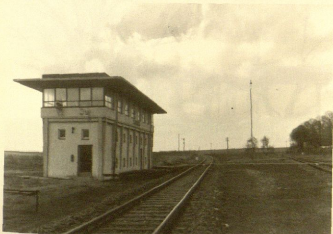
Das 1959 erbaute Stellwerk Jw
