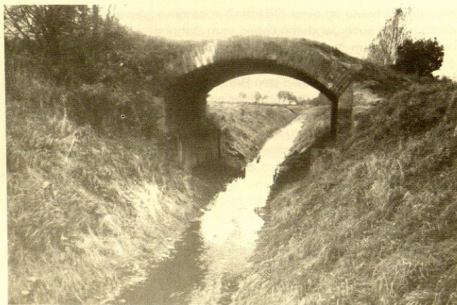
Brückenrest der Halberstädter Strecke über den Mittelgraben im Großen Bruch
