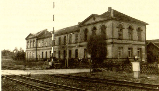
Heutiges Empfangsgebäude, jetzt Gastwirtschaft "Kastanienhof"
