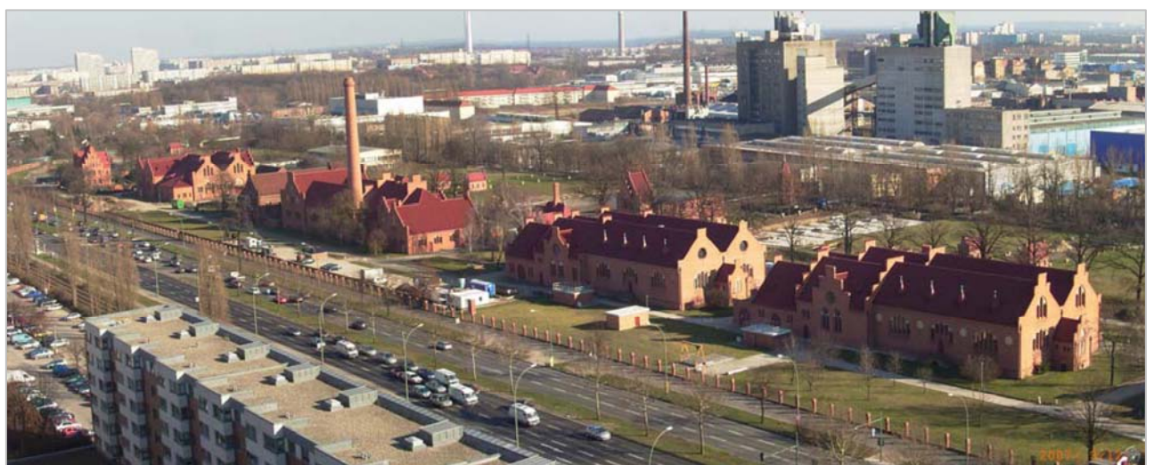
Zwischenpumpwerk Landsberger Allee, Berlin-Lichtenberg
