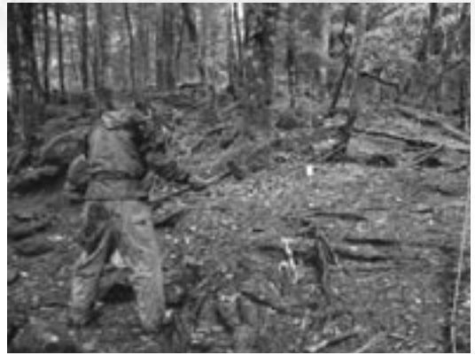
保護ロープの杭打ち
