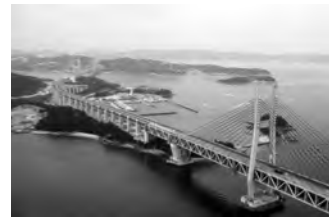
児島一坂出ルートの櫃石島橋(香川県)
