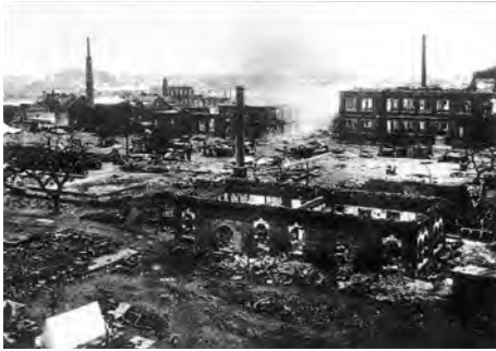
関東大震災により無残な姿をさらす校舎(大正12年)
