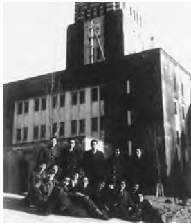
昭和23年3月の本館。戦時下の名残りの迷彩が施されている
