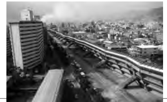
阪神大震災で倒壊した阪神高速道路
