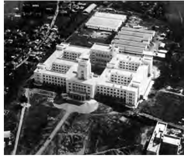
完成した本館全景(昭和13年)
