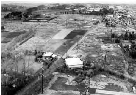
大学本館の建設予定地
