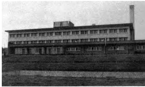
松風学舎(横浜市青葉区松風台・昭和52年)
