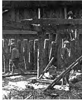
松杭が林立する工事中の地下部分
