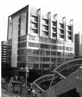
田町キャンパスイノベーションセンター（CIC）。7～9階が東工大スペース
