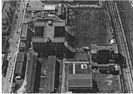
附属工業高等学校の全景(昭和46年)
