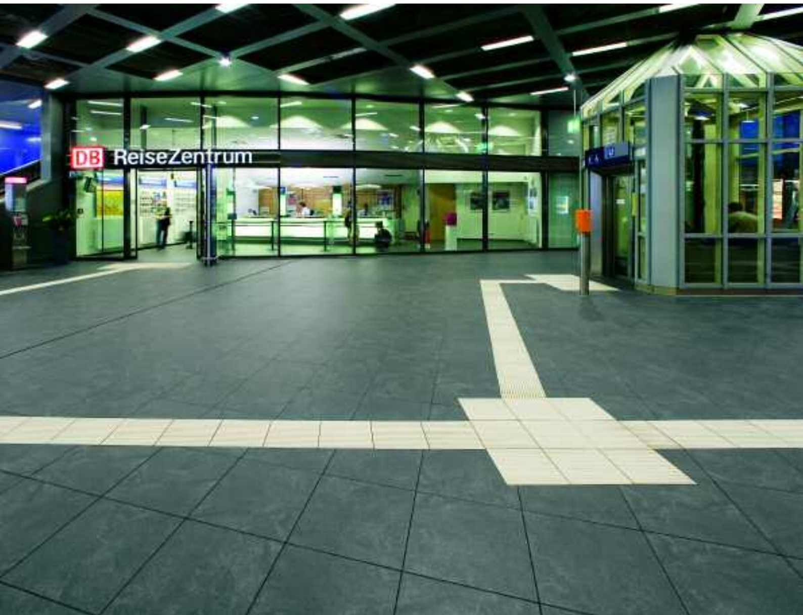
Hauptbahnhof, Gelsenkirchen, Deutschland, Serie Metry, Blindenleitsystem
