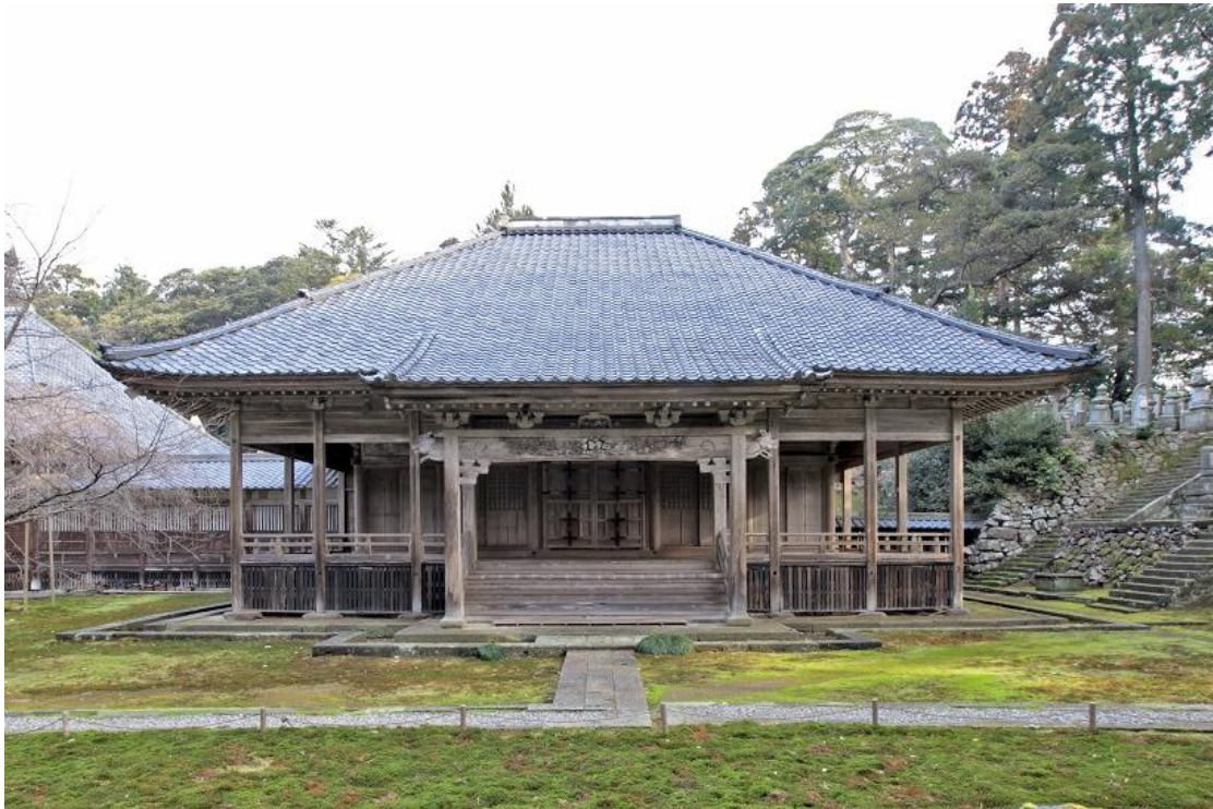
観音堂外観（南より）
