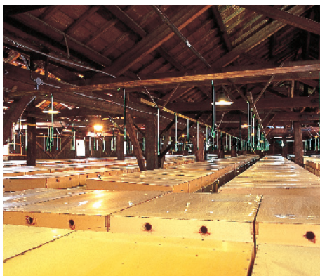
発酵室内の様子
