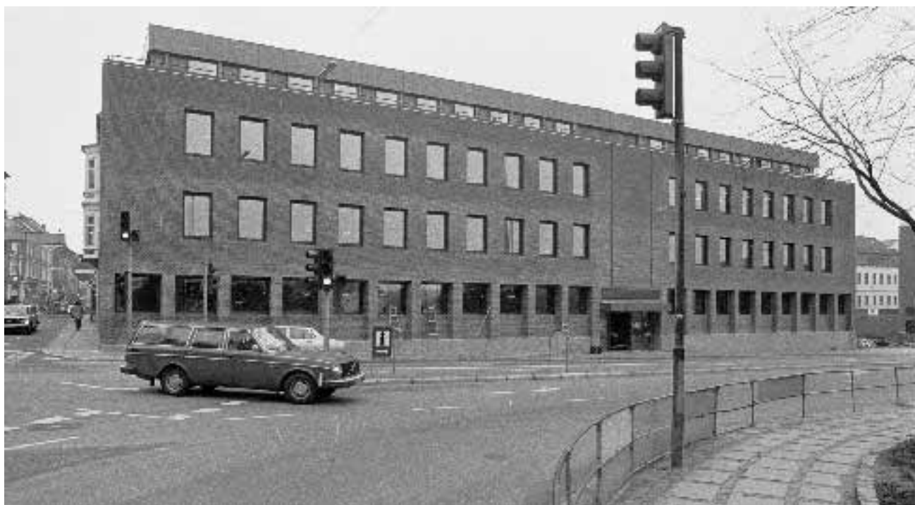
Kolding Kommunes administrationsbygning i Bredgade kort efter opførelsen i 1982.
