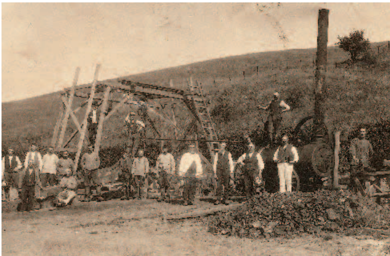
Arbejde på anlægget af Kolding Vandværk, der kunne indvies i 1886.
